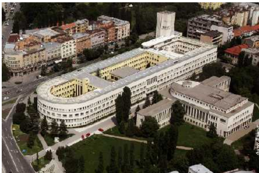
Зграда Извршног већа АП Војводине (тзв. зграда Бановине) 15
